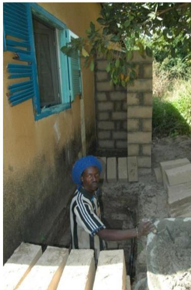
Malang, le maçon creuse la fosse septique et de filtration, tout en construisant le local technique qui devra recevoir le compresseur et l'aspirateur.
